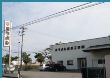
▲ ミツボシ繊維工業株式会社 久慈工場 外観
